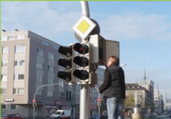
Exemple d'UBR. Source: Siemens
